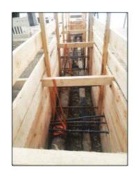
Dette armature devono essere applicate man mano che procede il lavoro di avanzamento; la loro rimozione può essere effettuata in relazione al progredire del rivestimento in muratura.
